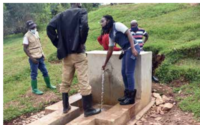
常時手洗いができるように水源を復旧
