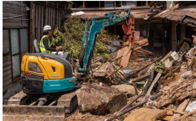
隣家に倒れかかっている壁の撤去の作業。倒壊しそうな建物を一部補強して重機の通り道を開き、この場所で作業を行っていました。
